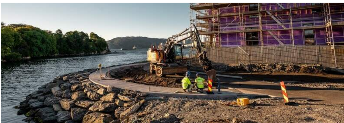
Boligprosjektet Paradis Brygge like ved Paradis stasjon i Stavanger. Bildet er fra byggingen av trinn 1. Byggestart trinn 2 er igangsatt og omfatter 132 leiligheter. Foto: Terje Borud
