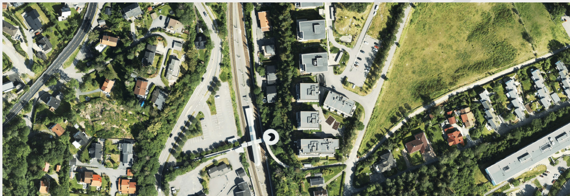
Vurdering av fremkommelighet ved stasjonene tar utgangspunkt i en del forhåndsdefinerte kriterier (se vedlegg 2). Her fra Slependen stasjon.
