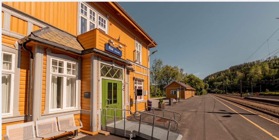
Vurdering av fremkommelighet ved stasjonene tar utgangspunkt i en del forhåndsdefinerte kriterier (se vedlegg 1). Her fra Roa stasjon. Foto: Terje Borud
