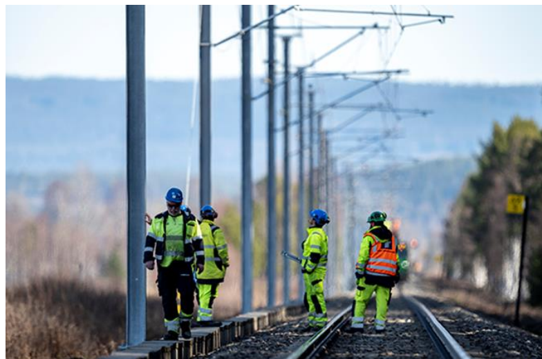
Arbeid i spor på Kongsvingerbanen. Foto: Bane NOR
