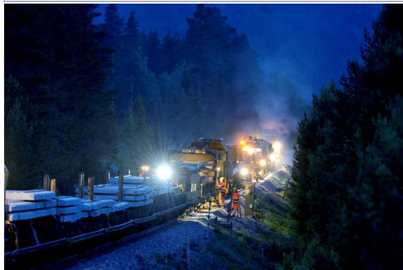
Svillbytte på Rørosbanen. Foto: Øystein Grue
