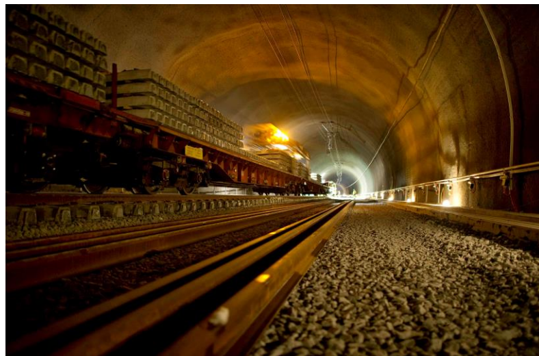
Skinnelegging i Bærumstunnelen. Foto: Hilde Lillejord.
