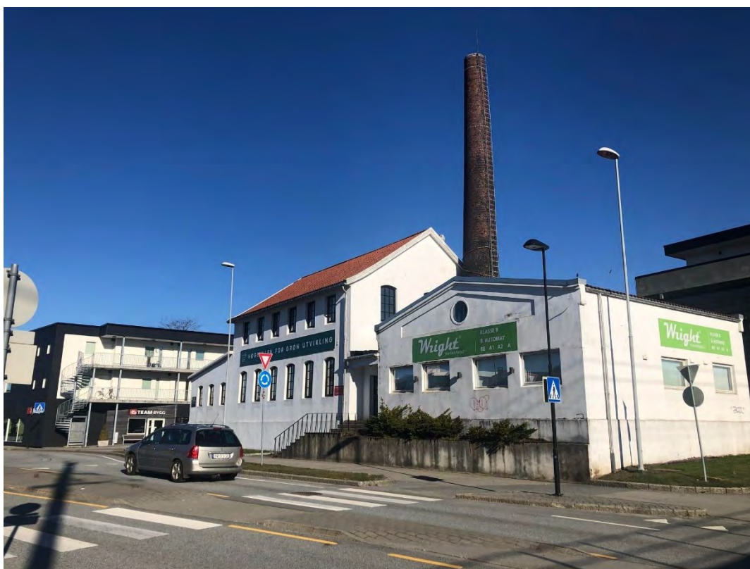
Figur 32: Holmen er den eldste industribygningen i stasjonsbyen, oppført som Jæderens Uldvarefabrik i 1896. Foto: F.-A.H. Stylegar/Multiconsult, 2022
