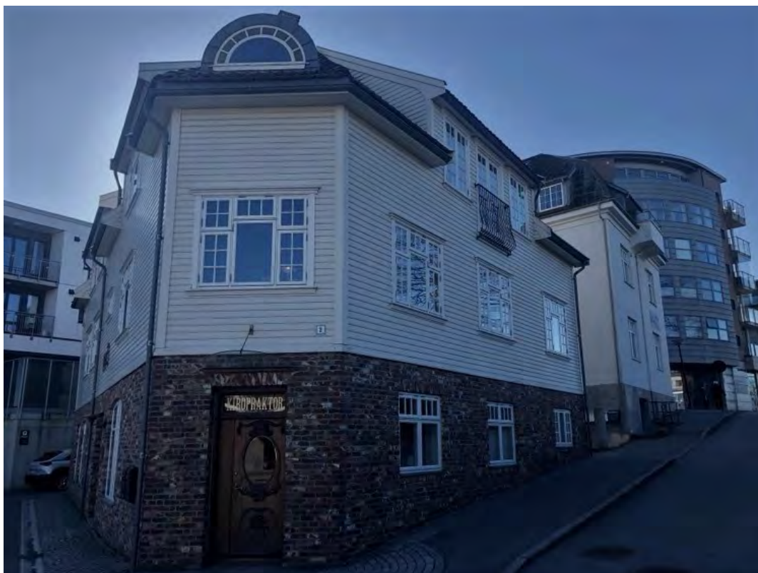
Figur 33: «Haualandshuset» fra 1918 var tidligere bolig, frisørsalong og kafé. Bygningen ble etter restaurering tildelt kommunens kulturverpris i 2003. Foto: F.-A.H. Stylegar/Multiconsult, 2022
